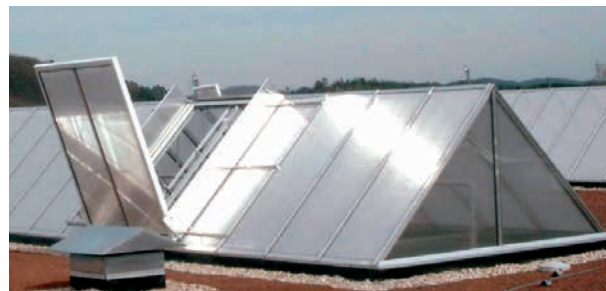
VARIO-FIREJET® 65° sistem cu trape individuale (EKS) pentru EKS-TH cu deschidere de 65°, montat în triunghiular special VARIO-THERM-S
