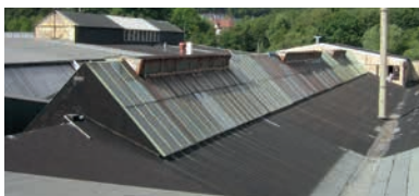
Luminator cu etrier cu geam armat cu plasă înaintea renovării
